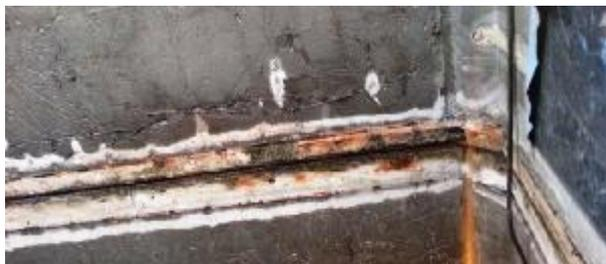
Infiltrazioni di acqua dalle giunture, guaina di protezione che si è già staccata in più punti dal soffitto, coperture in metallo sulle pareti laterali arrugginite, pareti completamente annerite.
